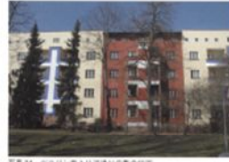
写真24 ベルリン街トリア通りの集合住宅
