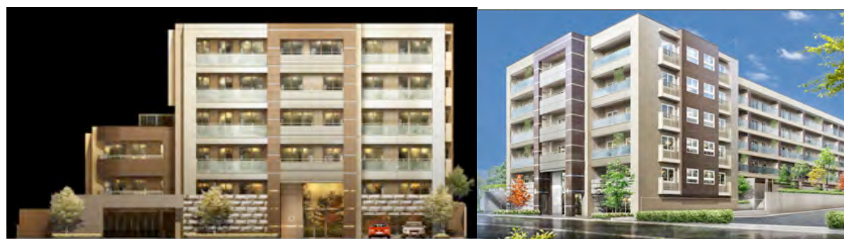
ファスタージュ泉が丘サーモス ロイヤルロード 外観
