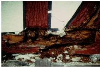
外皮の部材を適切に組み合わせないと腐朽の原因になります。
